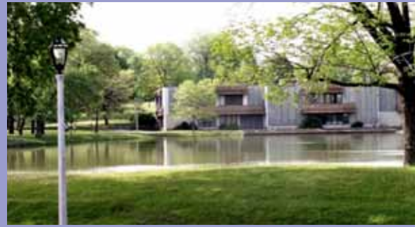
Kosciuszko Circle project
